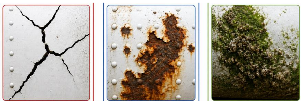
Изображения дефектов (слева направо): трещина, коррозия, обрастания
